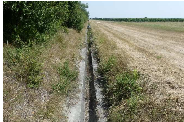
Fossé bétonné au nord du site
